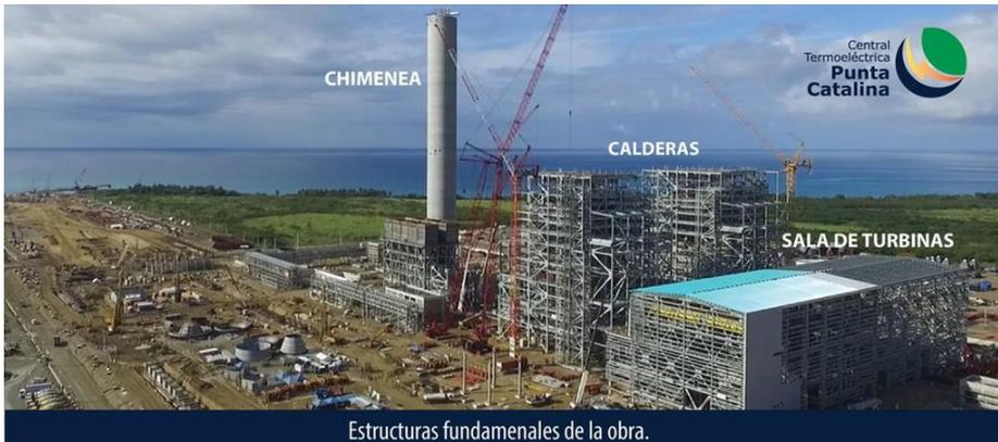
La termoeléctrica Punta Catalina podrá usar como combustible el equivalente al 10% del carbón que necesita. Esto, al consumir en briquetas de basura el equivalente a 2,600 toneladas de basura diarias.
